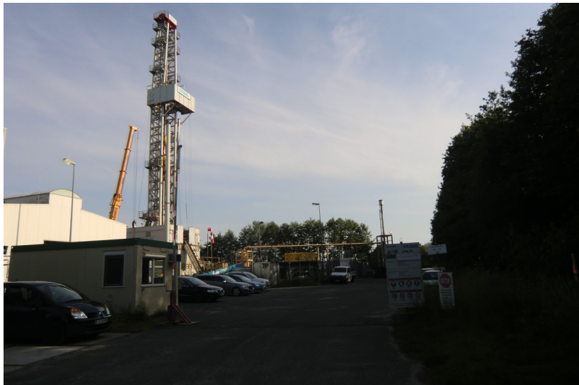
Bohrturm einer Fracking-Testbohrung in Niedersachsen
